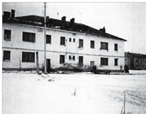
شکل ۲۹. یکی از ساختمان‌های دوطبقه در روستای جدید ورچانیو ترویتسا، هر ساختمان شامل ۱۶ واحد مسکونی
